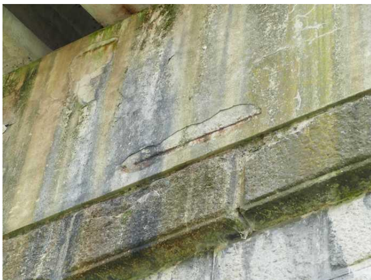
Pilíř P 05: Úložný práh, povrchová úprava odpadlá s obnaženou výztuží
