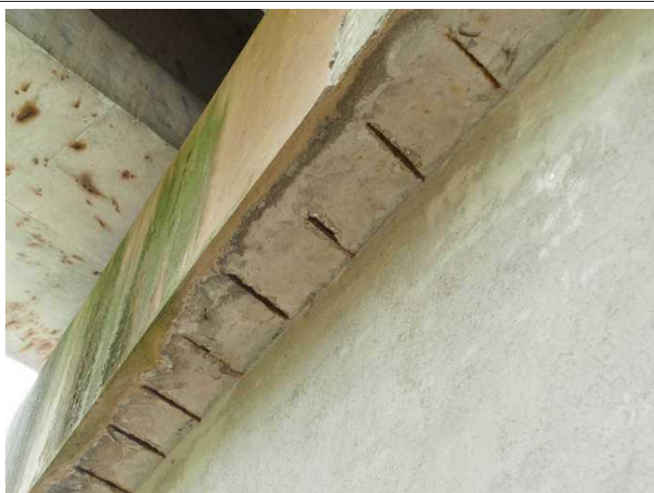
Pilíř P 01: Úložný práh, z podhledu obnažená výztuž s korozí
