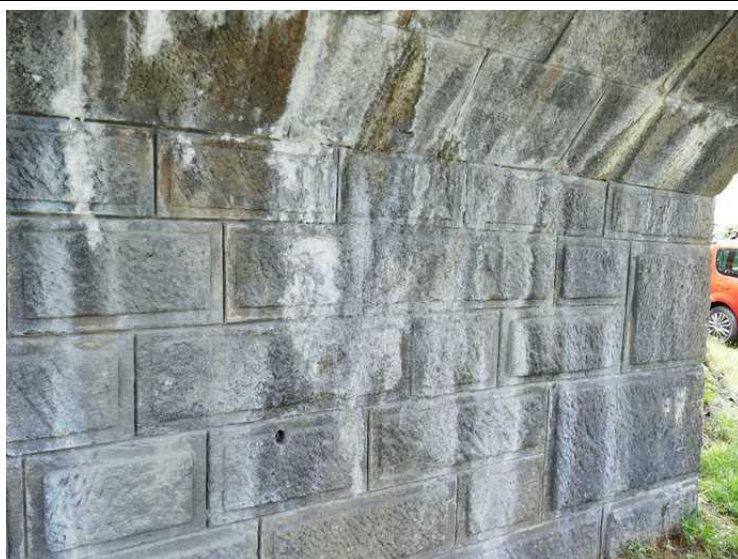
Opěra O 01: Stékání výluh pojiva a zvětralé kameny
