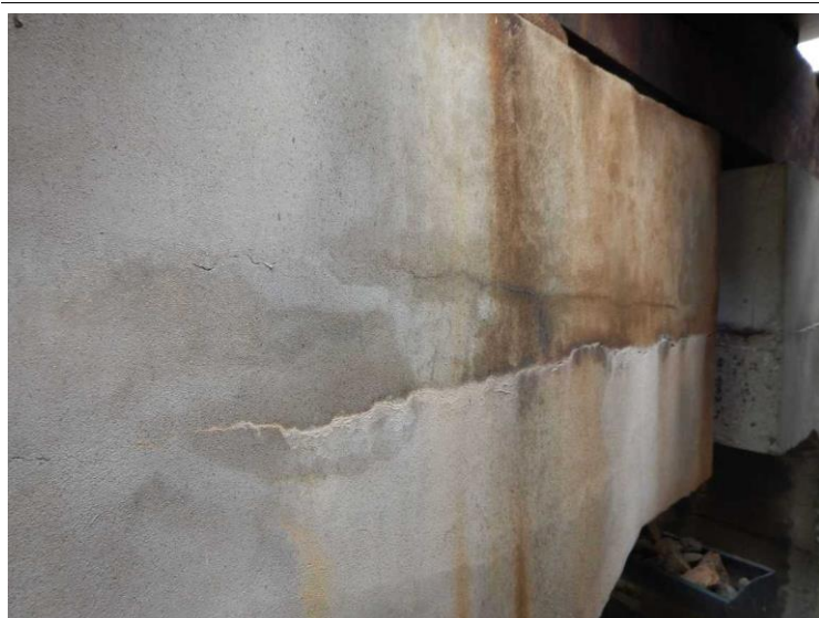
Konstrukce K 06: Z čela na začátku, vodorovná trhlina s výluhy pojiva
