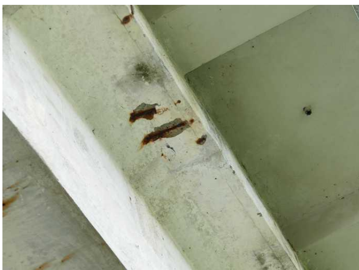
Konstrukce K 02: Z podhledu, obnažená výztuž s korozí
