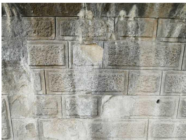
Pilíř P 01: V otvoru č. 1, zvětralé kameny
