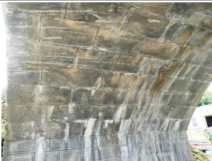
Konstrukce K 01: Z podhledu, průsaky vody s výluhy pojiva
