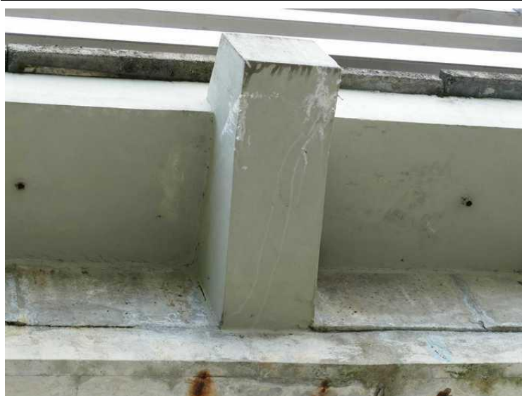
Konstrukce K 02: Římsa vlevo, betonová konzola trhliny s výluhy pojiva
