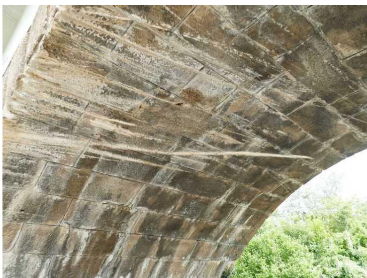
Konstrukce K 01: Z podhledu, rýhy
