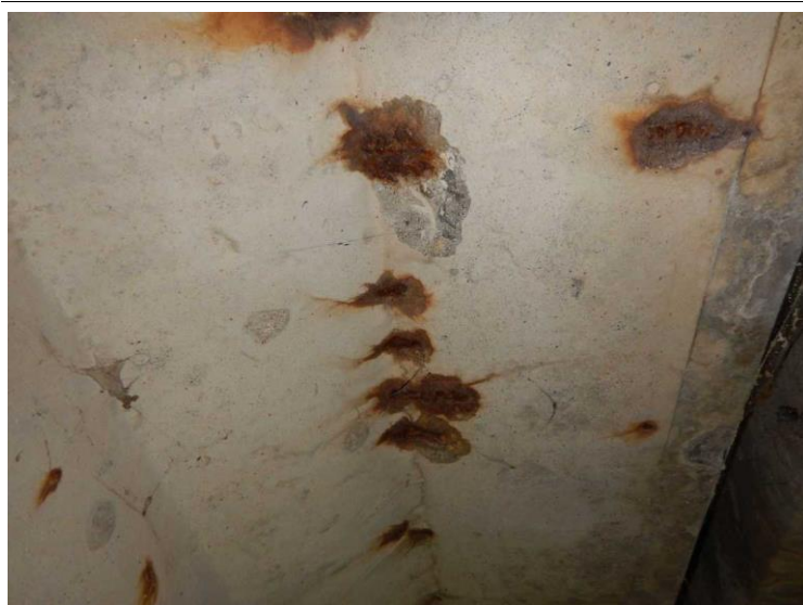
Konstrukce K 03: Z podhledu, obnažená výztuž s korozí
